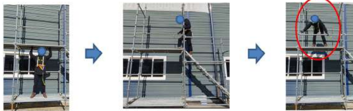
①상부 작업발판 설치 ②상부 작업발판으로 이동 ③안전난간 설치(추락위험)
