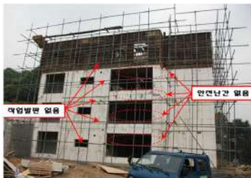
<과거 강관비계 설치현장>
