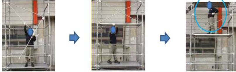
① 상부 안전난간 먼저 설치 ② 상부 작업발판 설치 ③ 상부 작업발판으로 이동
