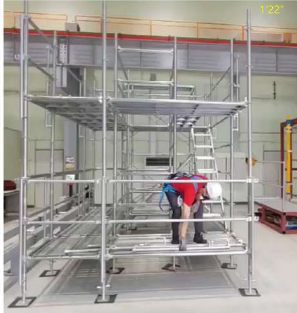
<수평 선행안전난간대 설치 영상>
