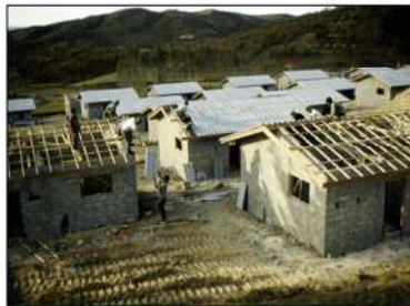
<1972년 수해민 임시주거시설 건설현장>
